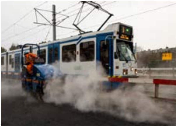
Aanbrengen van het nieuwe asfalt bij Kronenburg
