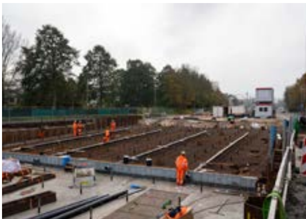
Inbrengen van funderingsankers bij de Sportlaan
