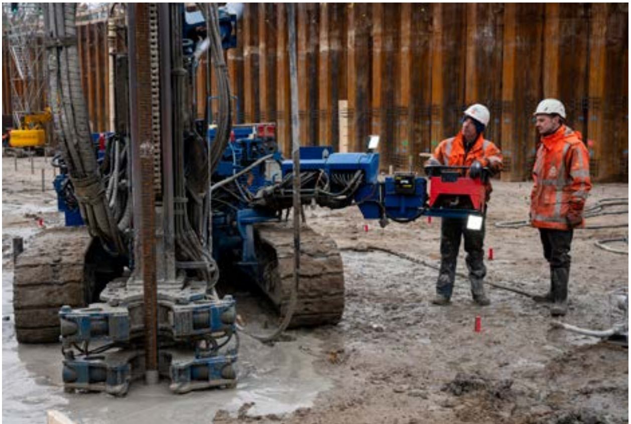
Inbrengen van funderingsankers bij de Sportlaan
