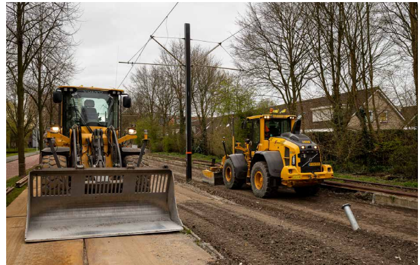
Vorbereidingen voor het aanleggen van de groene trambaan tussen Poortwachter en Scherpenhof
