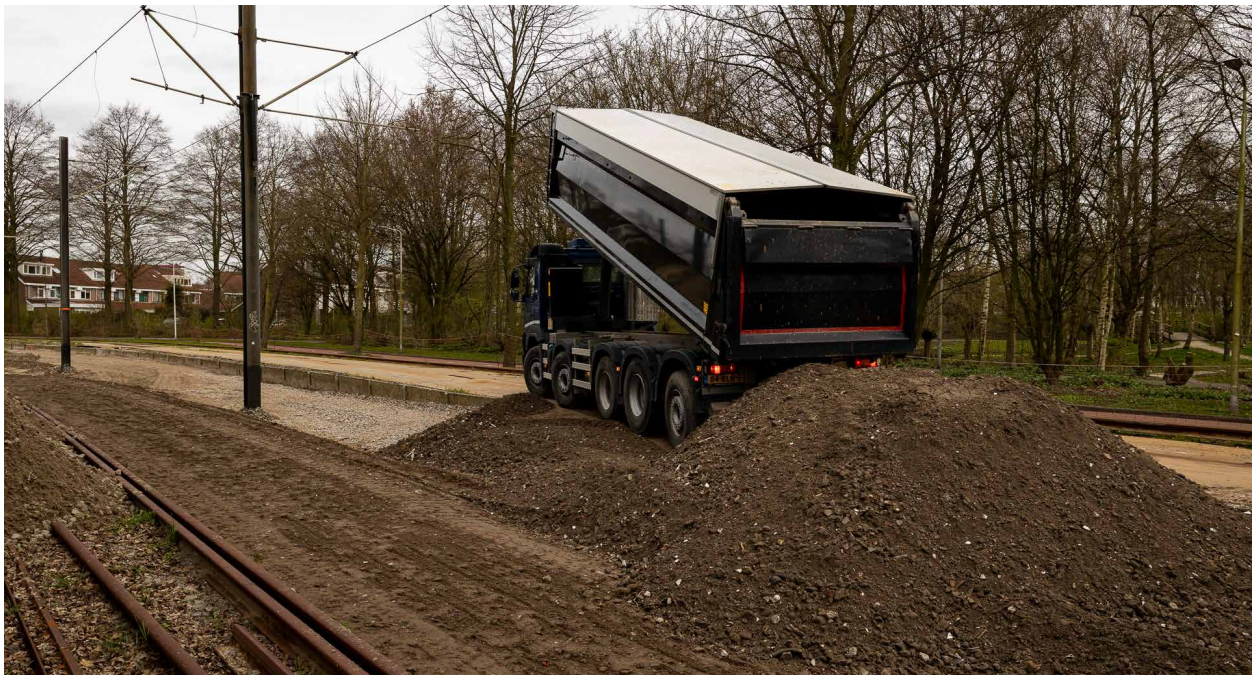
Spoorwerkzaamheden tussen Poortwachter en Scherpenhof
