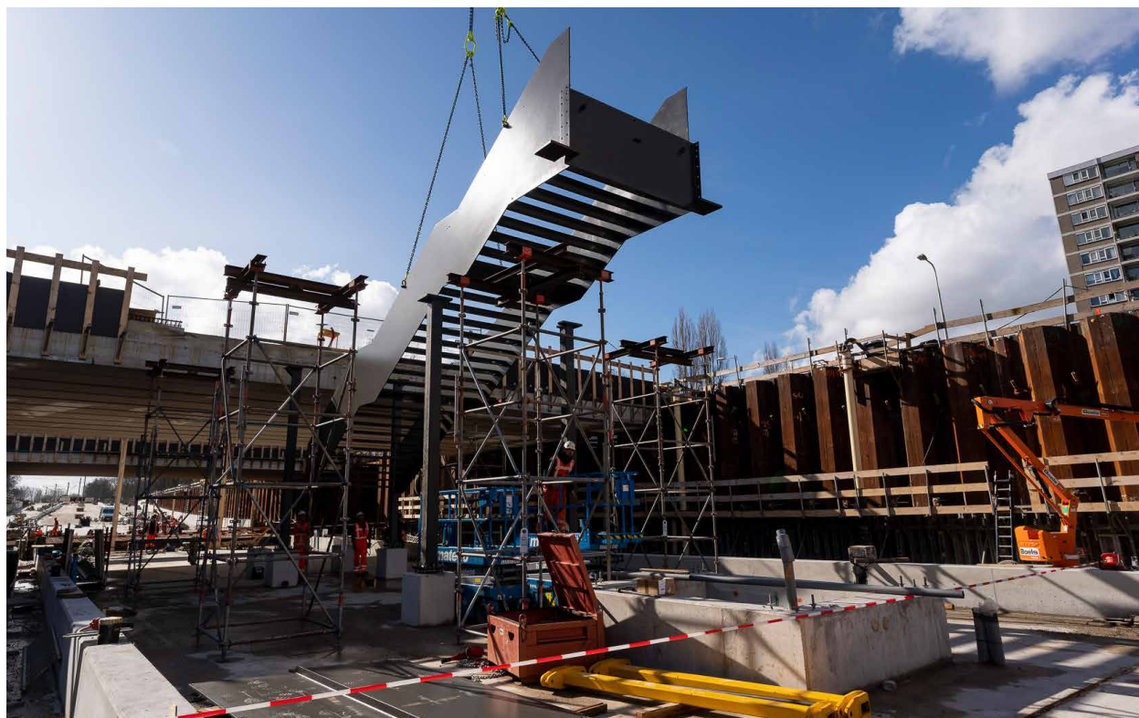
Plaatsing trap bij halte Sportlaan
