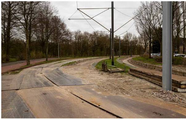
Spoorwerkzaamheden tussen Poortwachter en Scherpenhof
