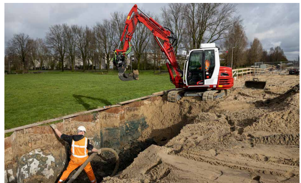
Leidingwerkzaamheden bij het Opstelsterrein
