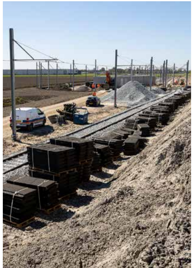
Spoorwerkzaamheden op het opstelrein
