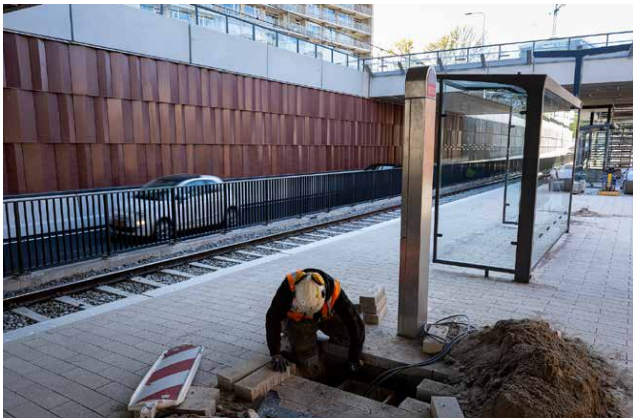
Werkzaamheden aan halte Zonnestein
