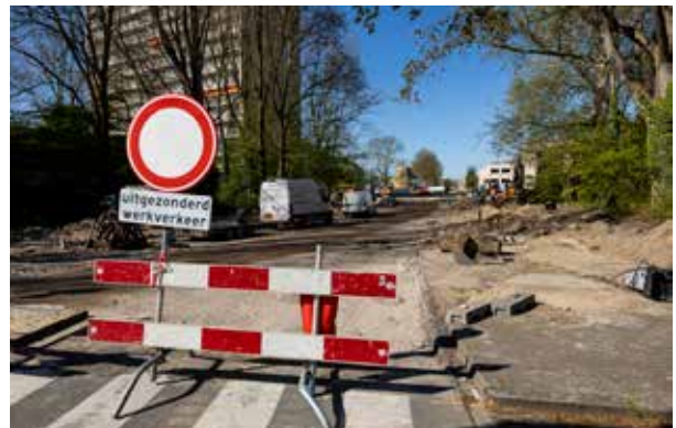
Werk aan de aansluiting van de Straat van Messina op de nieuwe rotonde Zonnestein
