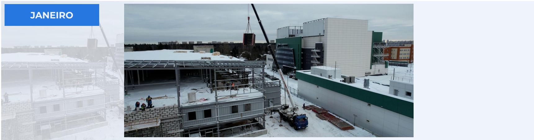
**ENCERRAMENTO DAS PAREDES DO TERCEIRO PISO, BETONAGEM DAS LAJES ENTRE PISOS EM DIFERENTES ANDARES. INÍCIO DAS TAREFAS DE ISOLAMENTO TÉRMICO**
