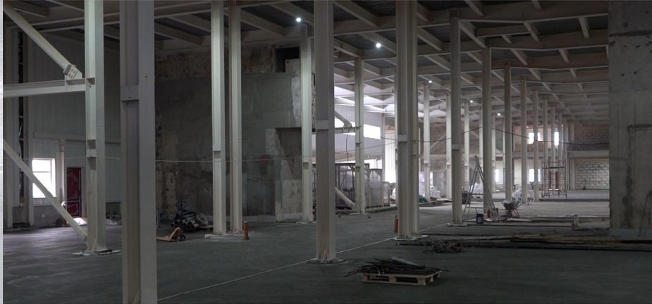
**PROCEDEU-SE À BETONAGEM DA ÚLTIMA “PARCELA” DO PAVIMENTO DO PRIMEIRO PISO DO DEPARTAMENTO D&E. A EQUIPA DE CONSTRUÇÃO AVANÇOU COM A INSTALAÇÃO DOS SERVIÇOS DE ENGENHARIA EXTERNOS, E O SISTEMA DE AQUECIMENTO PROVISÓRIO ESTÁ A POSTOS PARA SER UTILIZADO**
