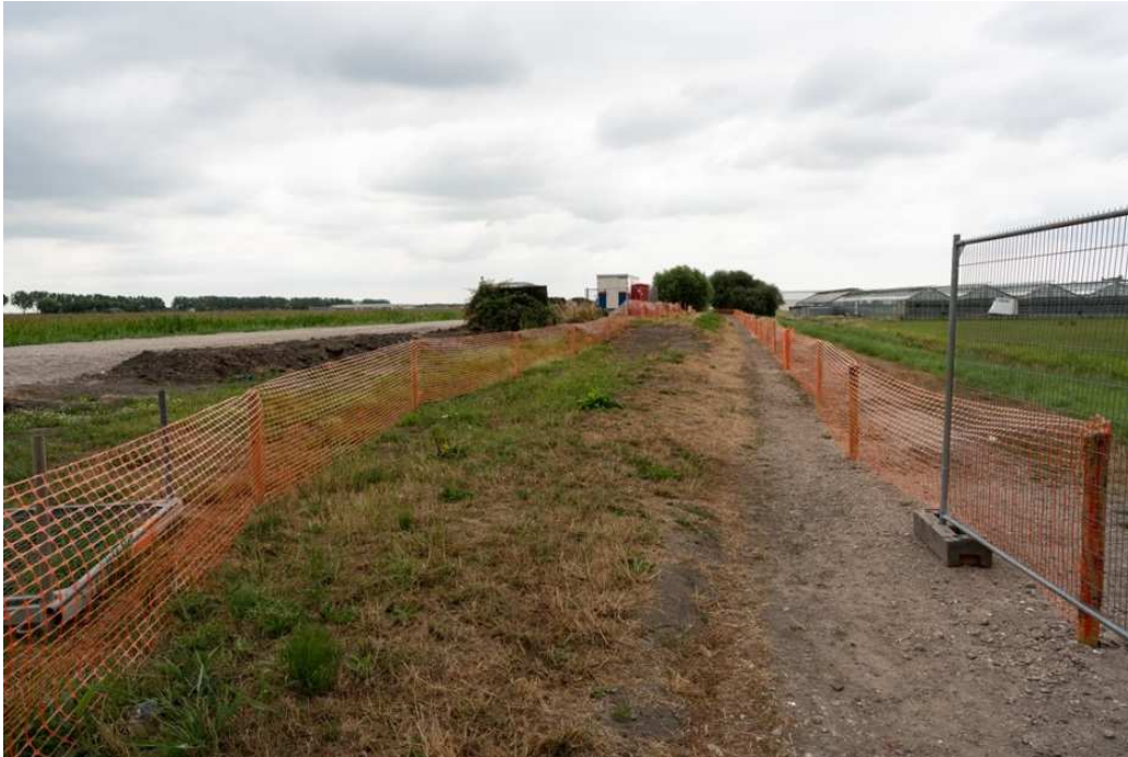
De locatie was eerder deze zomer het werkterrein voor het verleggen van kabels en leidingen bij de J.C. van Hattumweg. Foto: Gé Dubbelman.
