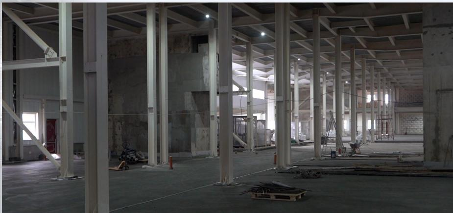
**LE DERNIER CARRÉ DE SURFACE AU REZ-DE-CHAUSSÉE DU BTEI A ÉTÉ COULÉ AVEC DU BÉTON. LES OUVRIERS ONT COMMENCÉ À INSTALLER LES SYSTÈMES DE VIABILISATION EXTERNES ET LE SYSTÈME DE CHAUFFAGE TEMPORAIRE A ÉTÉ CONNECTÉ**
