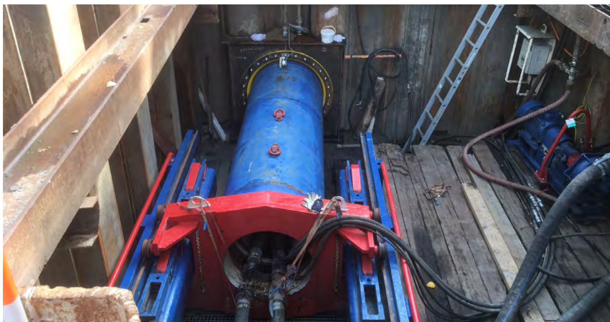
Verlegging persleiding bij Kronenburg en Zonnestein; de buis gaat onder de Beneluxbaan door.
