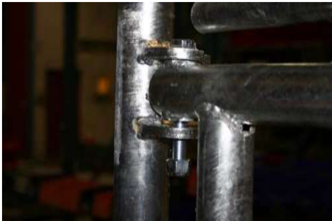
Låsning av front med bult – vänster sida
